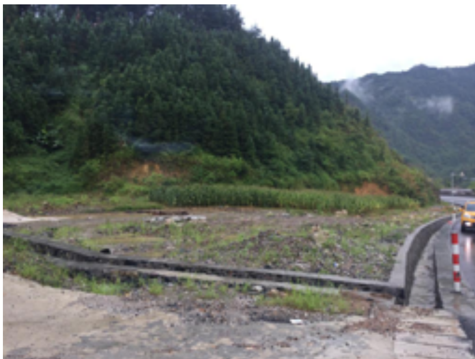
施工生产区（一）
