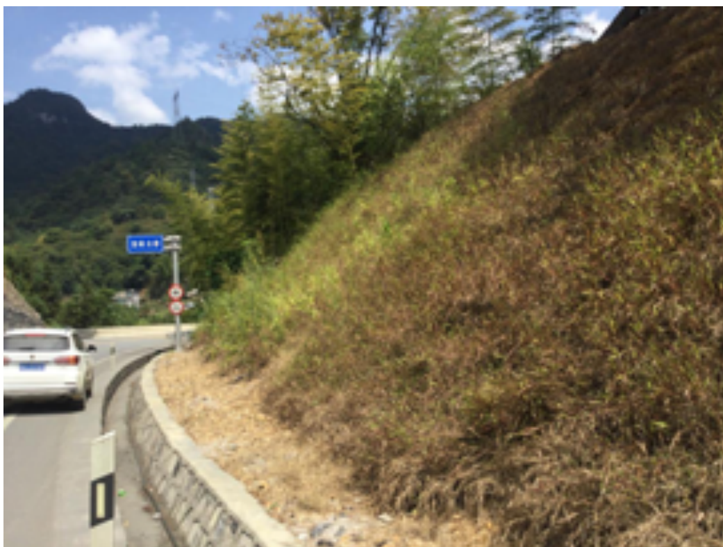
挖方边坡植草防护（二）
