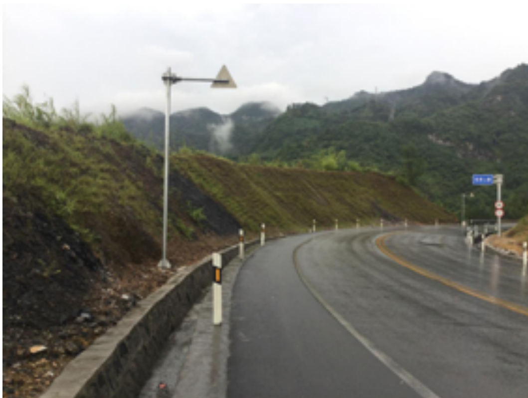
挖方边坡植草防护（一）
