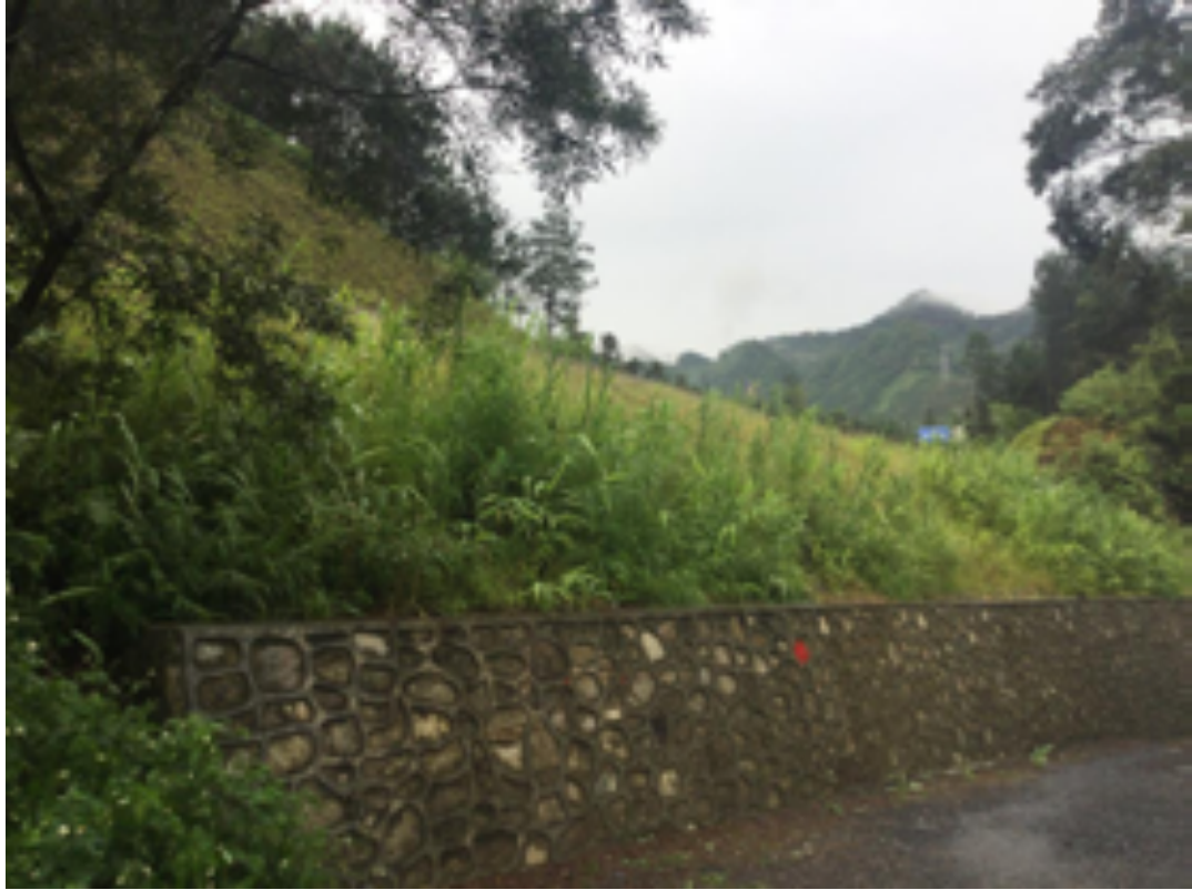
填方边坡植草防护（二）
