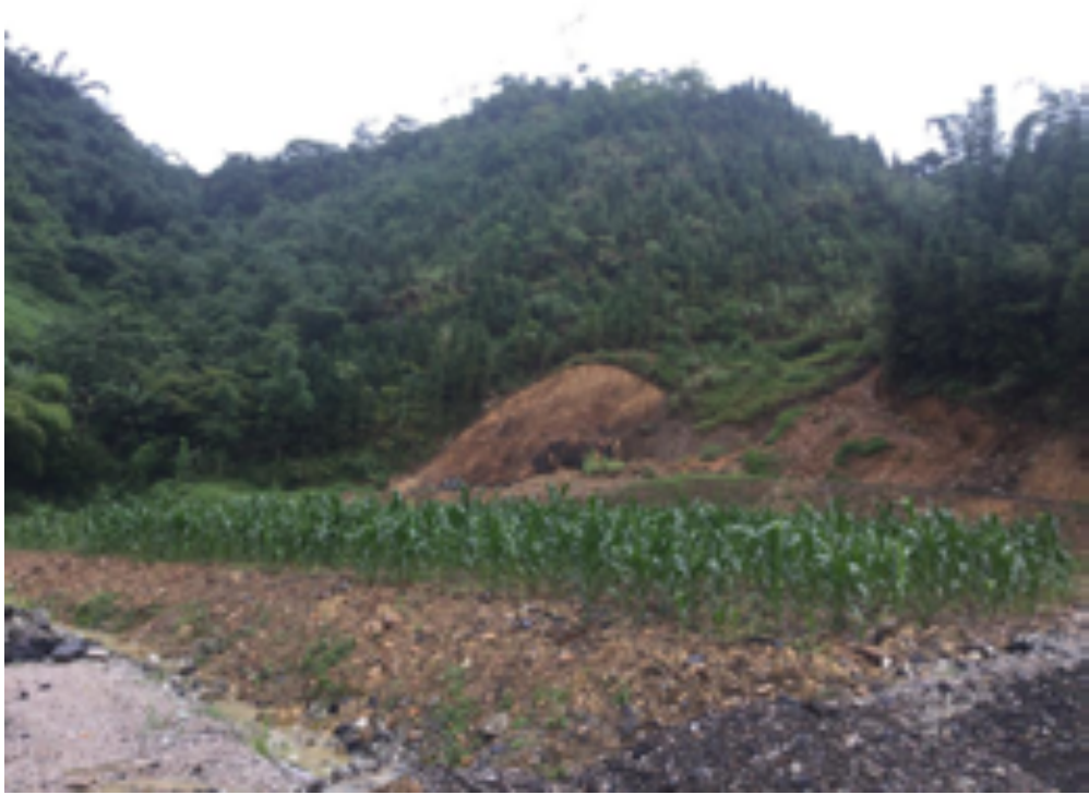
施工生产区（二）
