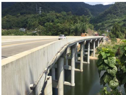
K0+957 灰岭大桥
