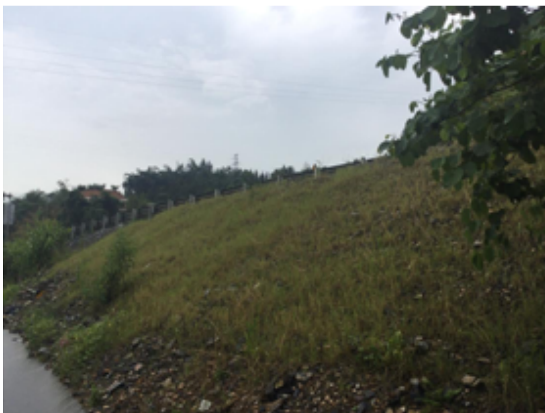
填方边坡植草防护（一）
