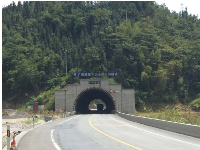
图 1.1-1 沿线隧道现状图
