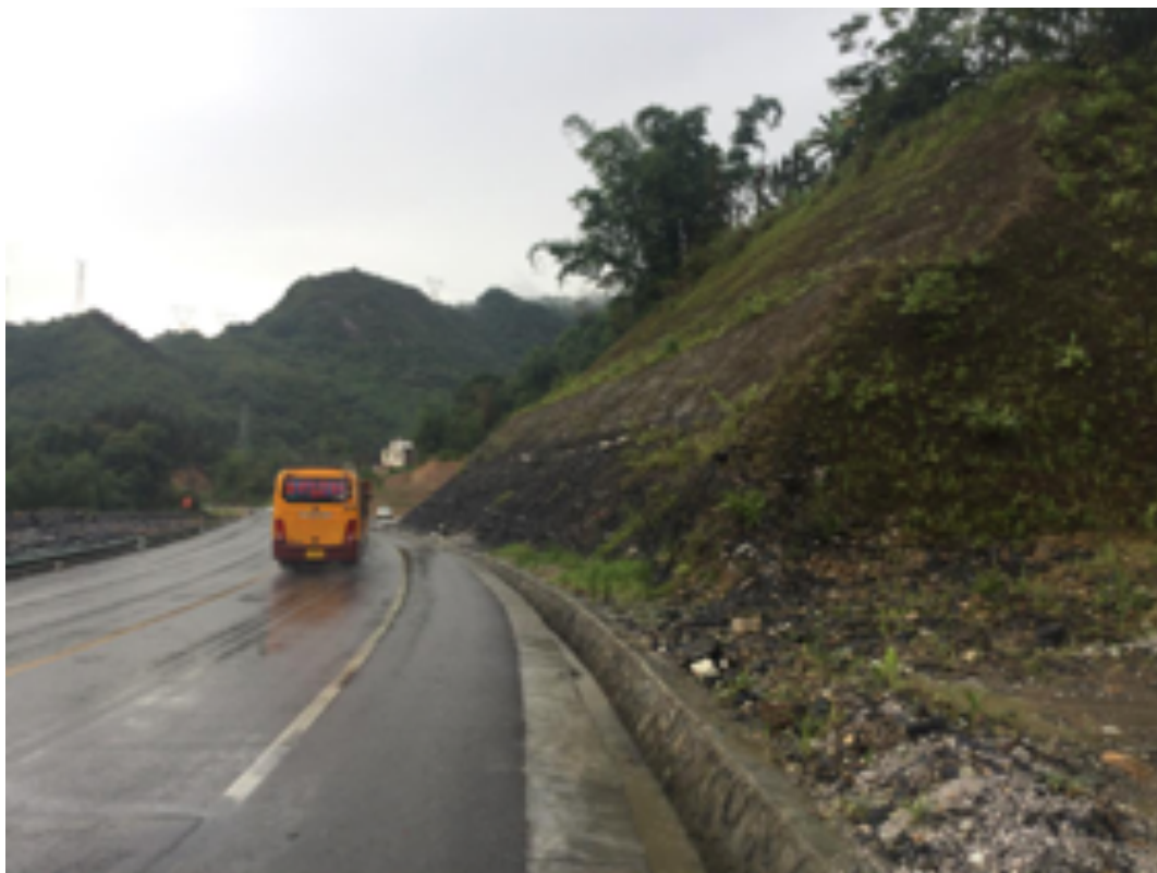
挖方边坡植草防护（三）
