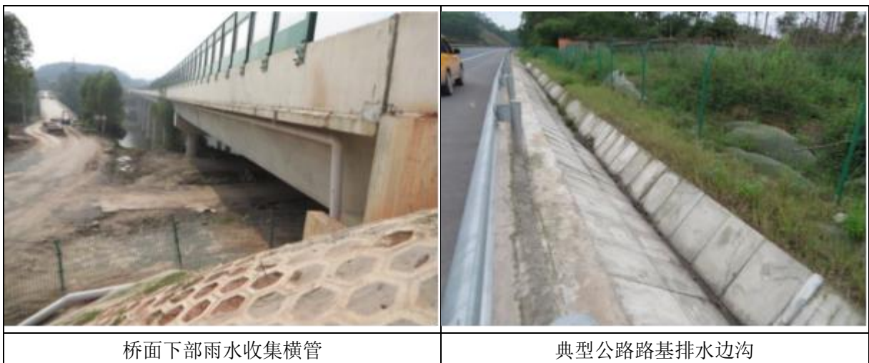
图5.5-1 典型桥面、路面径流收集系统实物图
