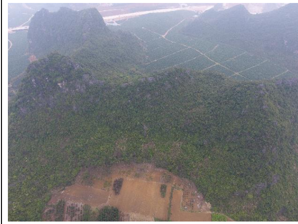
旧圩 1 号隧道进口
