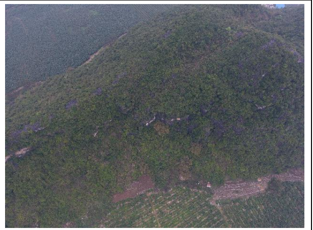
旧圩 2 号隧道出口
