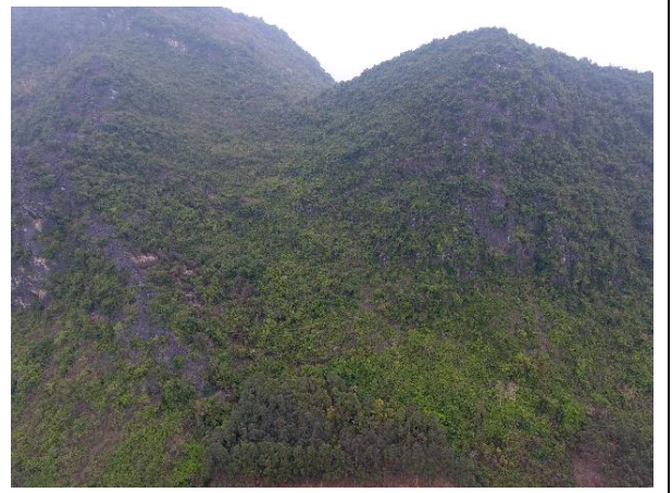
旧圩 1 号隧道出口
