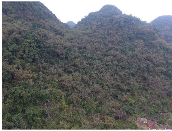
陇迳内隧道进口
