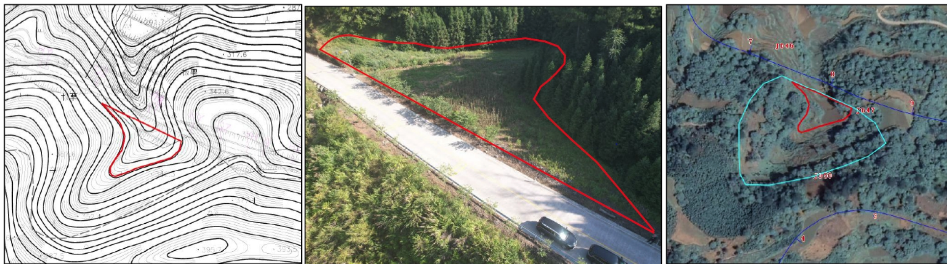
图 3.2.1.9 9#弃渣场 (K10+700 右) 地形图、现状照片及卫星影像图
