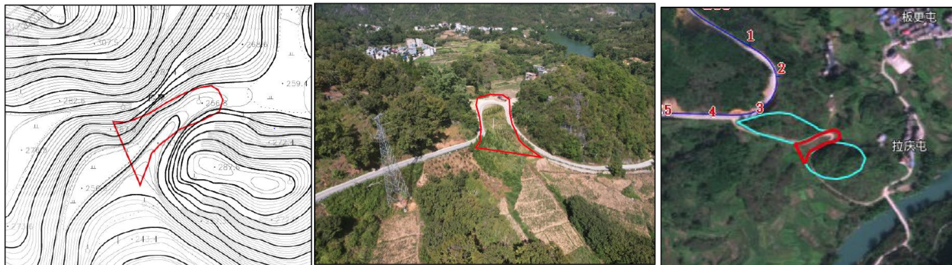
图 3.2.1-17 17#弃渣场 (K21+220 左 200m) 地形图、现状照片及卫星影像图
