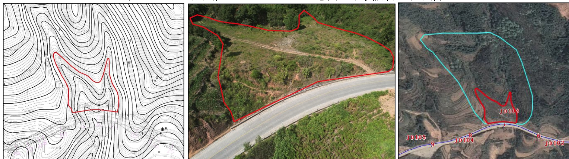
图 3.2.1-18 18#弃渣场 (K21+700 右) 地形图、现状照片及卫星影像图
