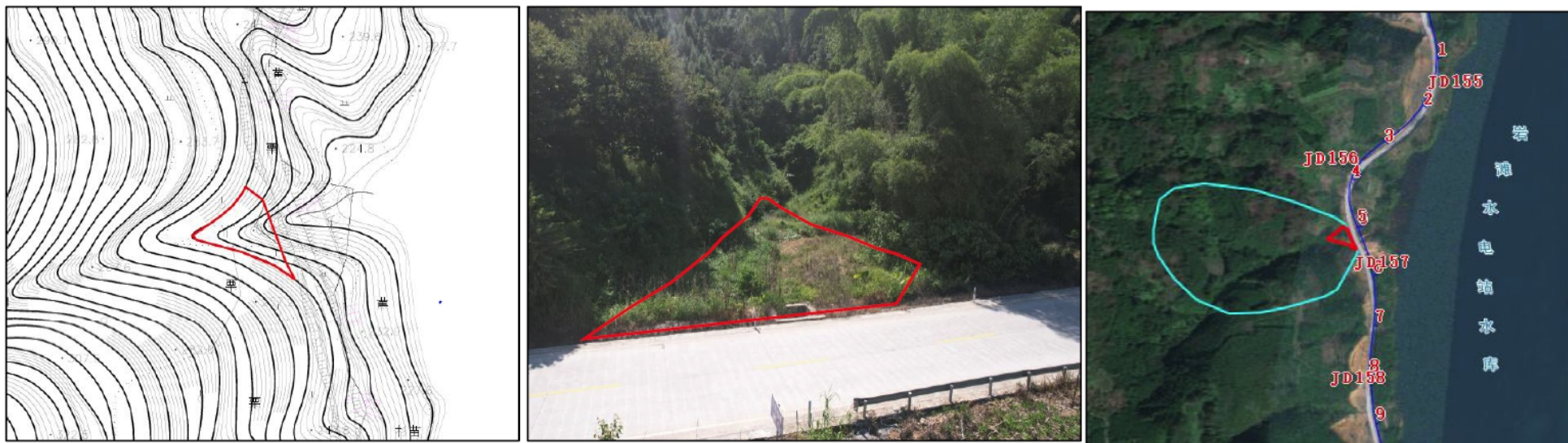
图 3.2.1-23 24#弃渣场 (K35+600 右) 地形图、现状照片及卫星影像图
