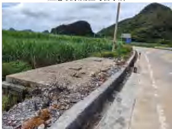
K42+490 左侧沉淀池及应急池
