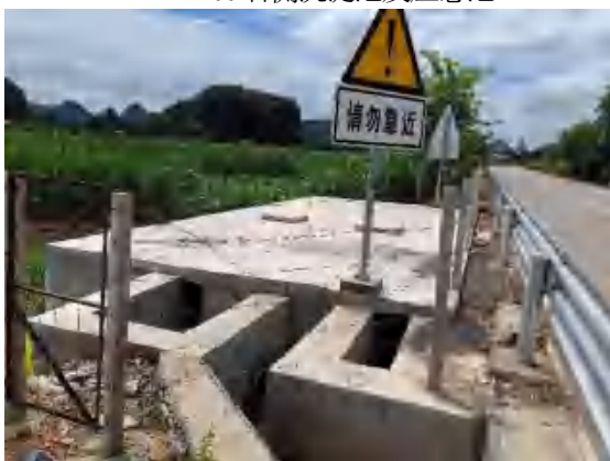
K42+900 左侧沉淀池及应急池
