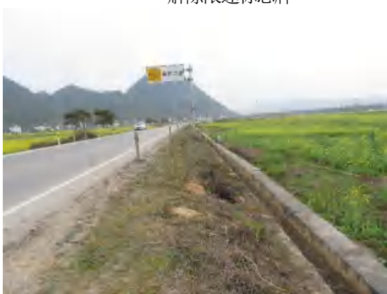
坡面排水边沟
