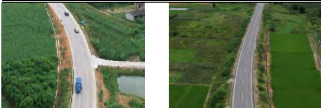
边坡排水边沟
