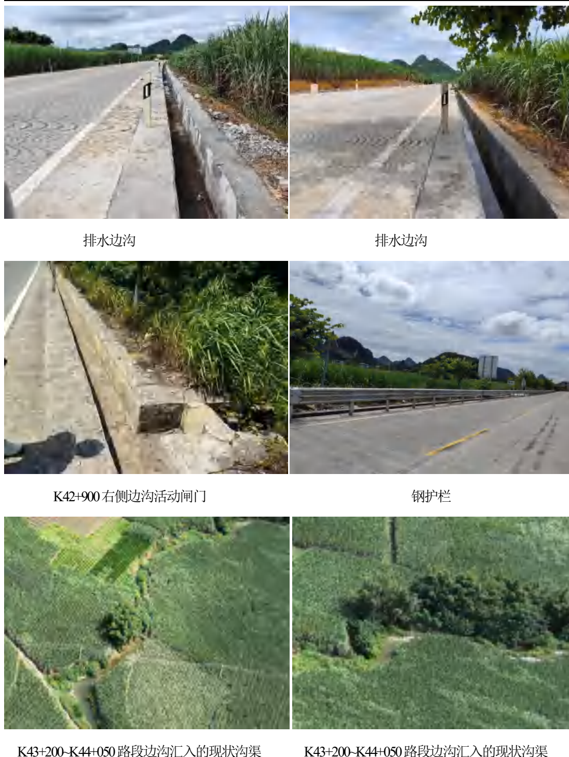
图 5.3-10 穿越鹿寨县平山镇饮用水水源保护区路段环境风险防范设施现状图
