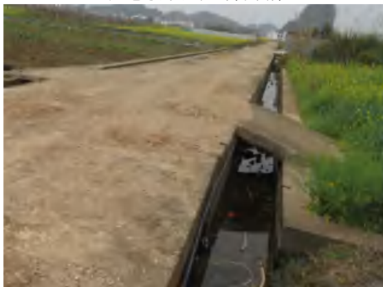
公路排水边沟衔接的路侧沟渠现状
