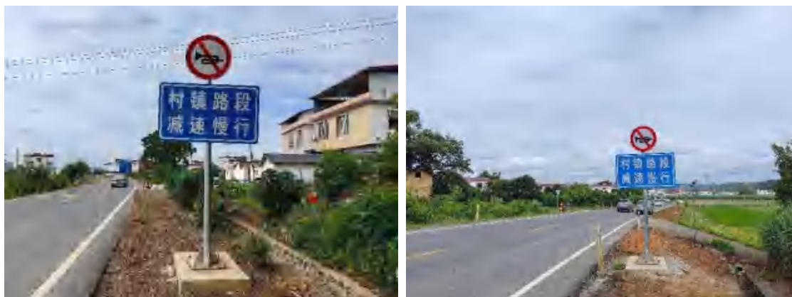
图 5.3-3 已采取的降噪措施措施现状图
