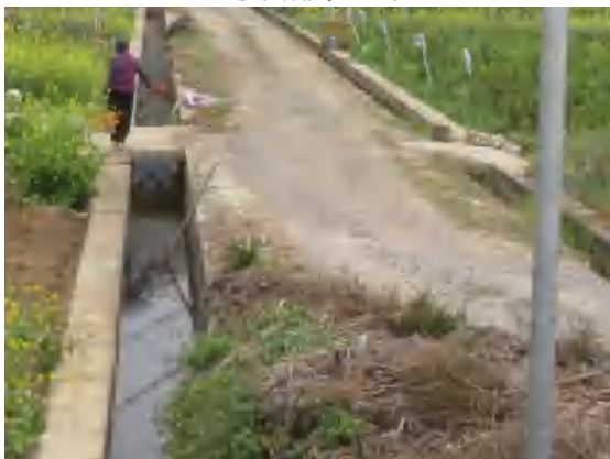
公路排水边沟衔接的路侧沟渠现状
