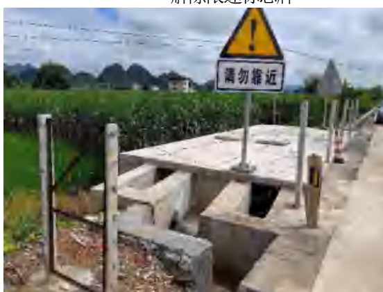
K42+100 右侧沉淀池及应急池
